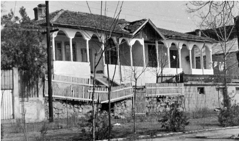
Casa lui Hagi Tănase Țoncovici, unul din silistrenii stabiliți la Călărași, construită în anii 1837-1838, așa cum arăta în anul 1960. A fost demolată după Cutremurul din martie 1977
