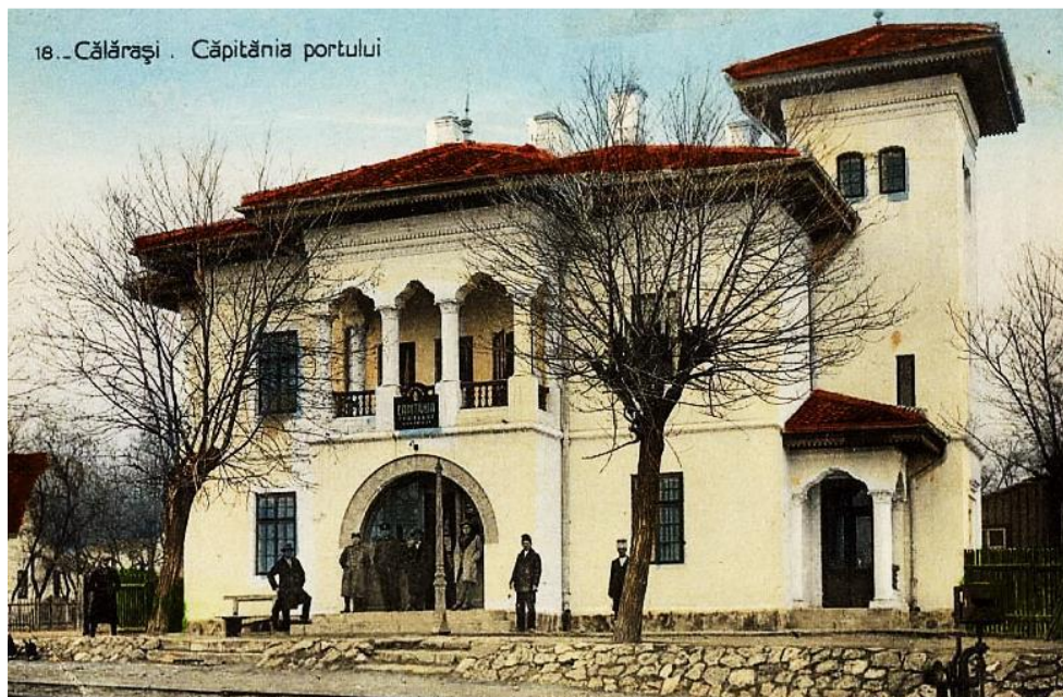
Căpitănia Portului Călărași construită în anii 1904-1905 după planurile inginerului Anghel Saligny.
