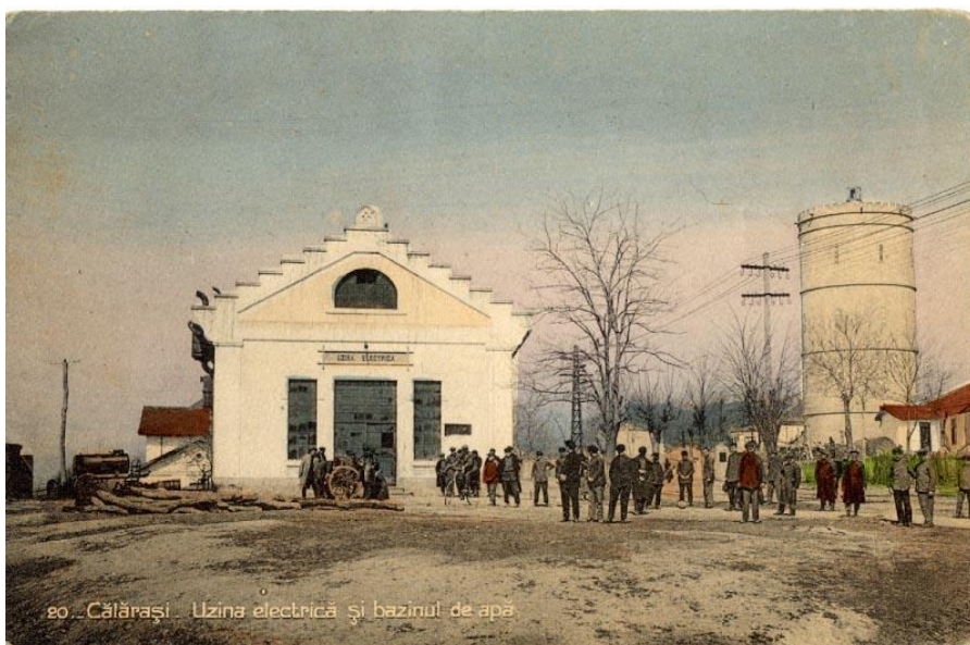
Turnul de apă, construit de firma Wolf în anul 1909 și Uzina electrică, ridicată în anul 1913 de firma austriacă Brown-Boveri
