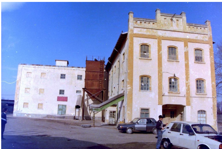
Clădirea de la intersecția străzilor Slobozia cu București și Moara Mircea, clădiri impozante construite în anul 1912 de călărășeanul Mircea Ionescu
