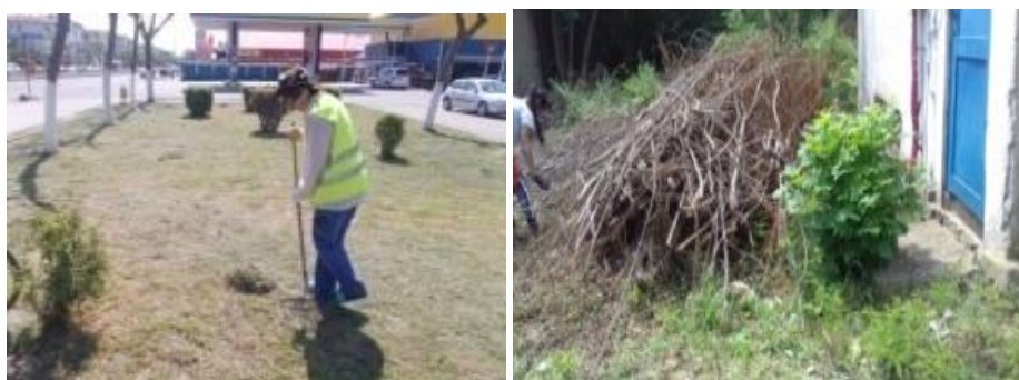
- Săpat gropi manual în teren mijlociu, tare și foarte tare – 574 buc,
