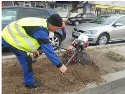
- Brăzduirea terenului pe orizontală la 5 cm – 4.350mp,
